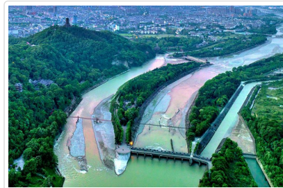
都江堰 水利工程
