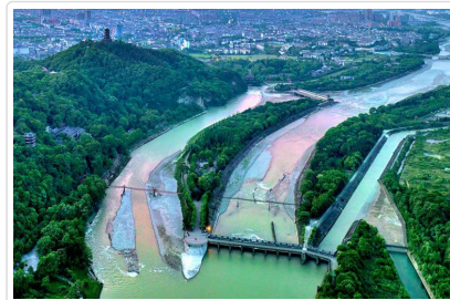
都江堰 水利工程
