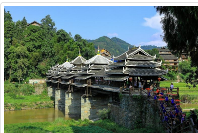
程陽八寨 風雨橋
